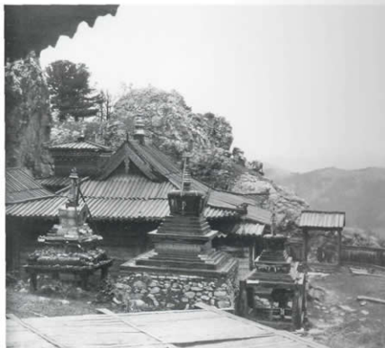
1 Tuvchun Chijid, das »Meditationshaus« (tuvchun; tib. 'grub-khang) des Janabajar in einem Seitental des Orchon, 40 Kilometer südwestlich von Erdeni Joo, Aufnahme von 1937. Die drei Stüpas sind nach dem Vorbild der Bodhi-Stüpa (tib. byang-chub mchod-rtan ) aus Holz gebaut; nur die Kuppel ist mit Blechen verkleidet.
